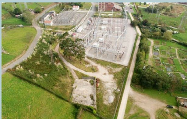
Foto aérea del aspecto de la subestación
